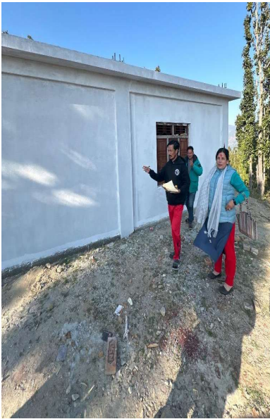
विद्यालयको अधुरो भवन निर्माण वड नं ९
